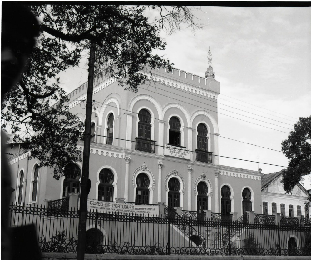
Palacete neoárabe localizado Rua Benfica, n.º 286, Madalena.
